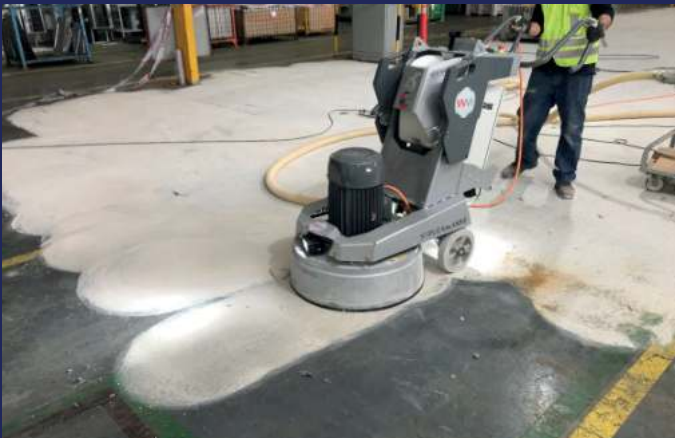
Pulido para retirar recubrimiento antiguo
